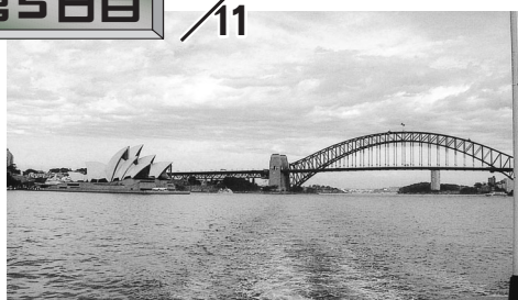
ハーバーブリッジ シドニー
